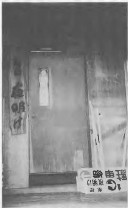
1966年に建設された稽古場
