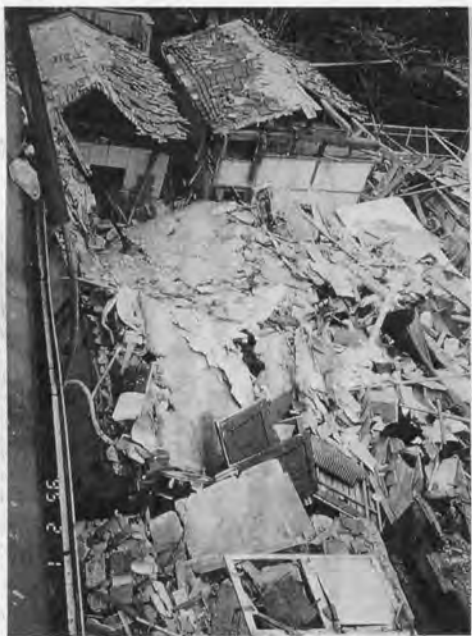
劇団どらの南側 落下した5階部分の残ガイと押し つぶされた民家
