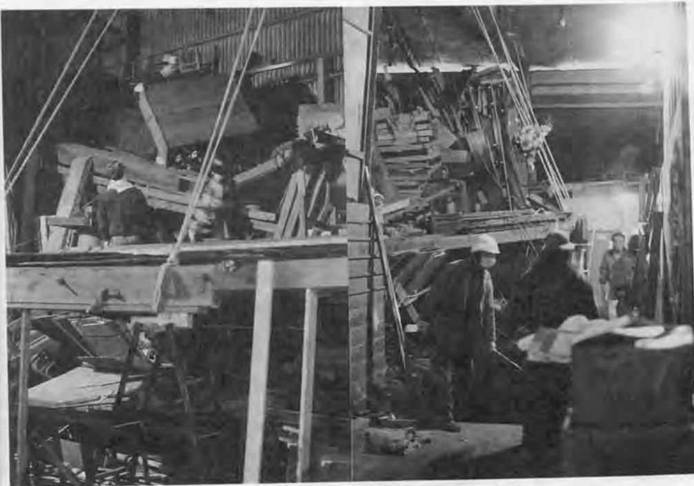
崩れた（倉庫）道具を片づけはじめる（劇団四紀会）
